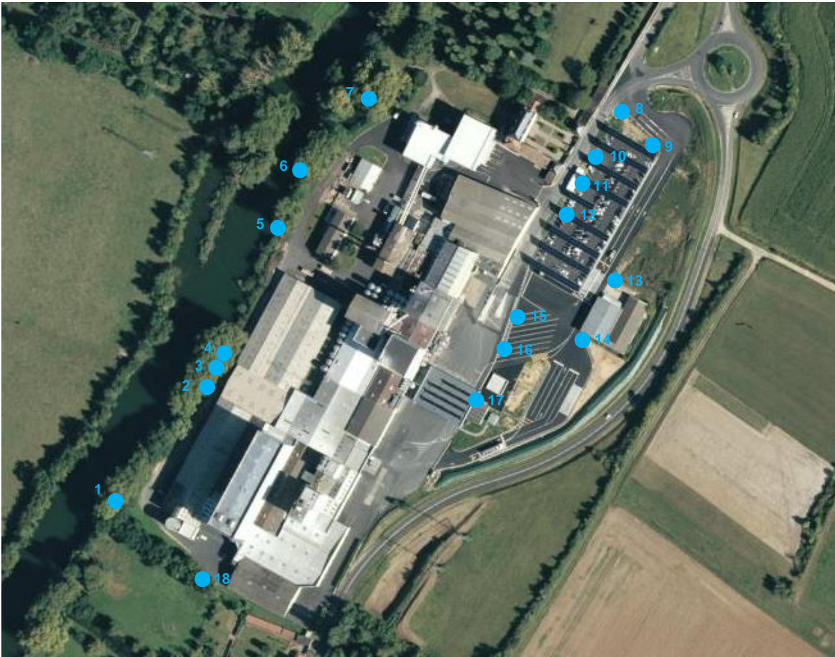
Figure 13 : Points de rejet d'eaux pluviales au milieu naturel
